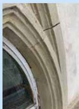
Außerdem werden gerade weitere Fugen zwischen den Steinen geschlossen, damit kein Wasser eindringen und das Mauerwerk schädigen kann. Ob vom Kostenvoranschlag noch Geld übrig bleibt, um weitere kosmetische Sanierungen durchzuführen, wird sich zeigen.
